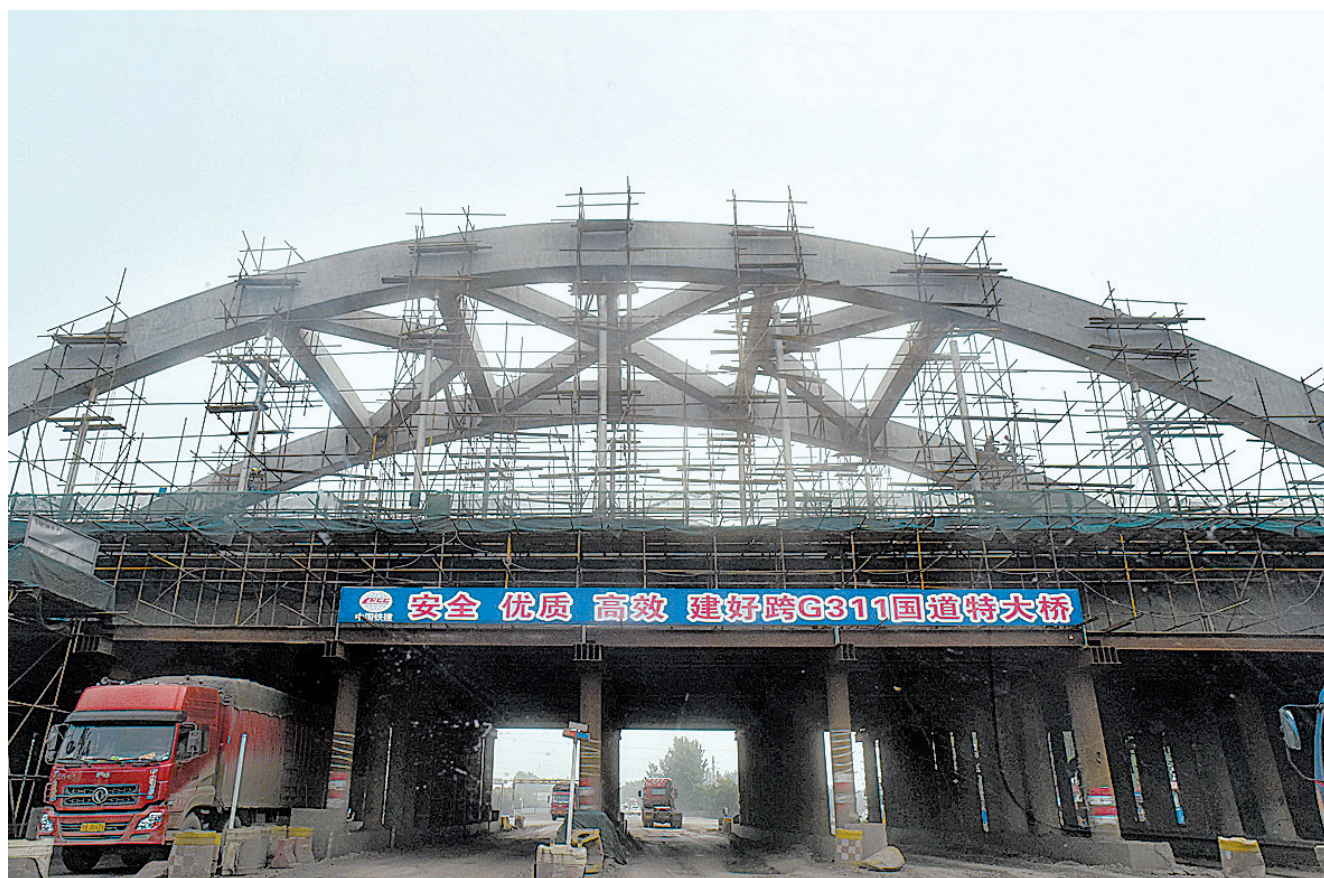
建好跨G311国道特大桥
