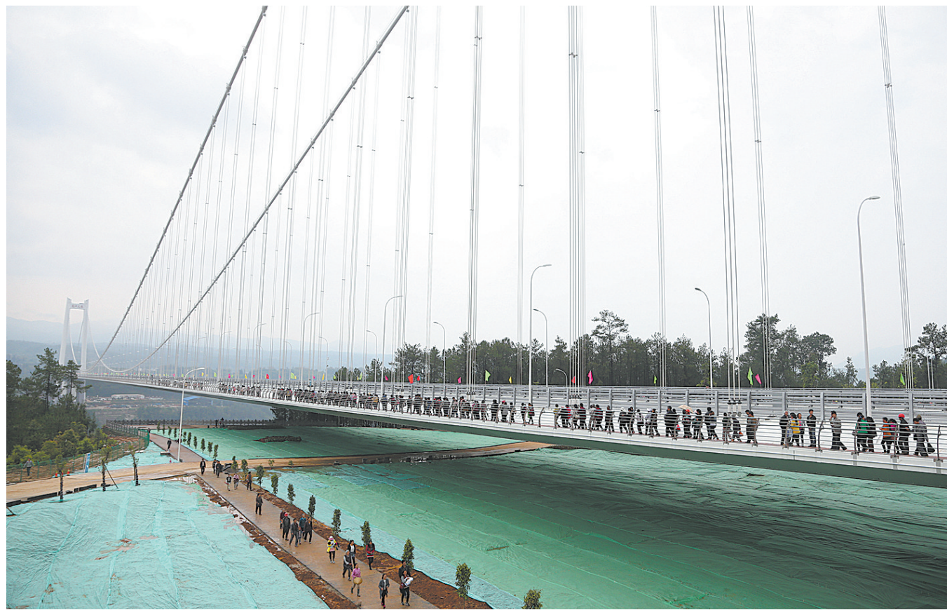
亚洲山区跨度最大钢箱梁悬索桥云南龙江特大桥建成通车
