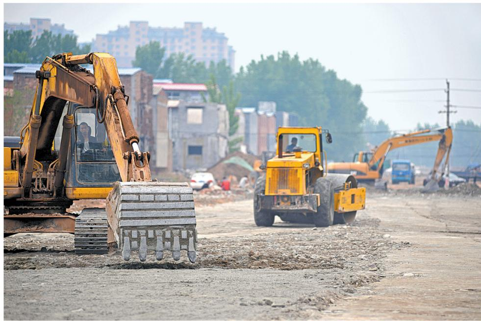
4月20日上午,施工人员和大型机械在市区开发二路南延道路施工现场忙碌。开发二路南延工程(神马大道至新南环路)全长1037米,道路规划红线宽度为40米,其中道路两侧分别有横断面(人行道)4米、非机动车道5米、绿化带3米,机动车道为16米。目前施工人员正在加紧施工,以确保道路早日建成通车。
