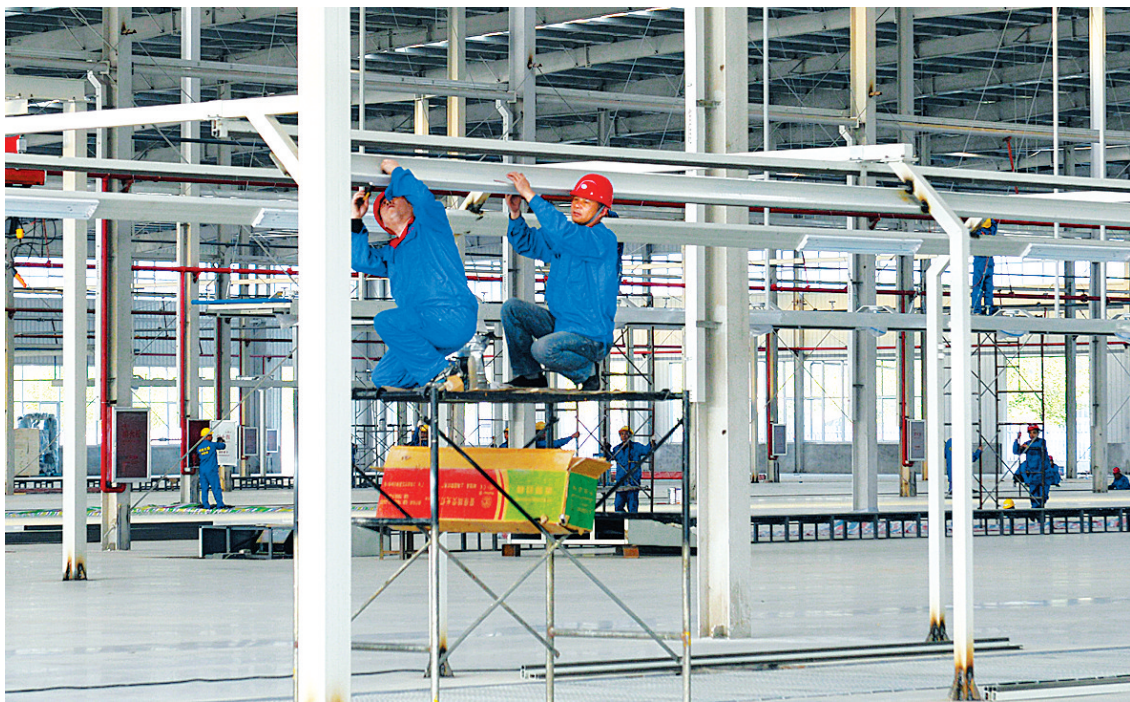
4月18日,工人在安装设备框架。
