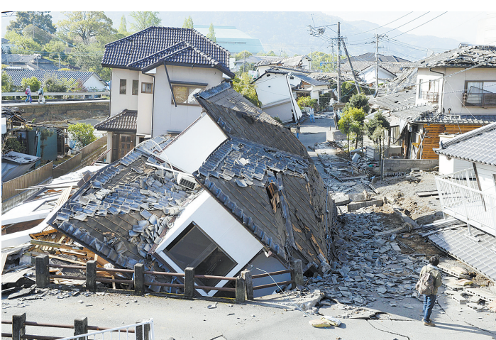
4月16日,在日本九州熊本县益城市,房屋在地震中毁坏。地震引发大规模山体滑坡、泥石流等二次灾害。熊本县东山区南阿苏村地震后发生大规模山体滑坡,灾情严重。 4月16日,在日本九州熊本县益城市,房屋在地震中毁坏。地震引发大规模山体滑坡、泥石流等二次灾害。熊本县东山区南阿苏村地震后发生大规模山体滑坡,灾情严重。 3000多人受伤。在重灾区熊本县南阿苏村,仍有11人失踪。 据日本广播协会17日报道,14、16日在熊本县发生的连环强震累计已造成至少41人遇难,3000多人受伤。在重灾区熊本
