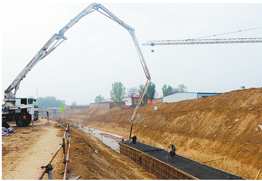
4月10日,工人们在暗涵施工现场配合泵车浇筑混凝土。 本报记者 王尧 摄
