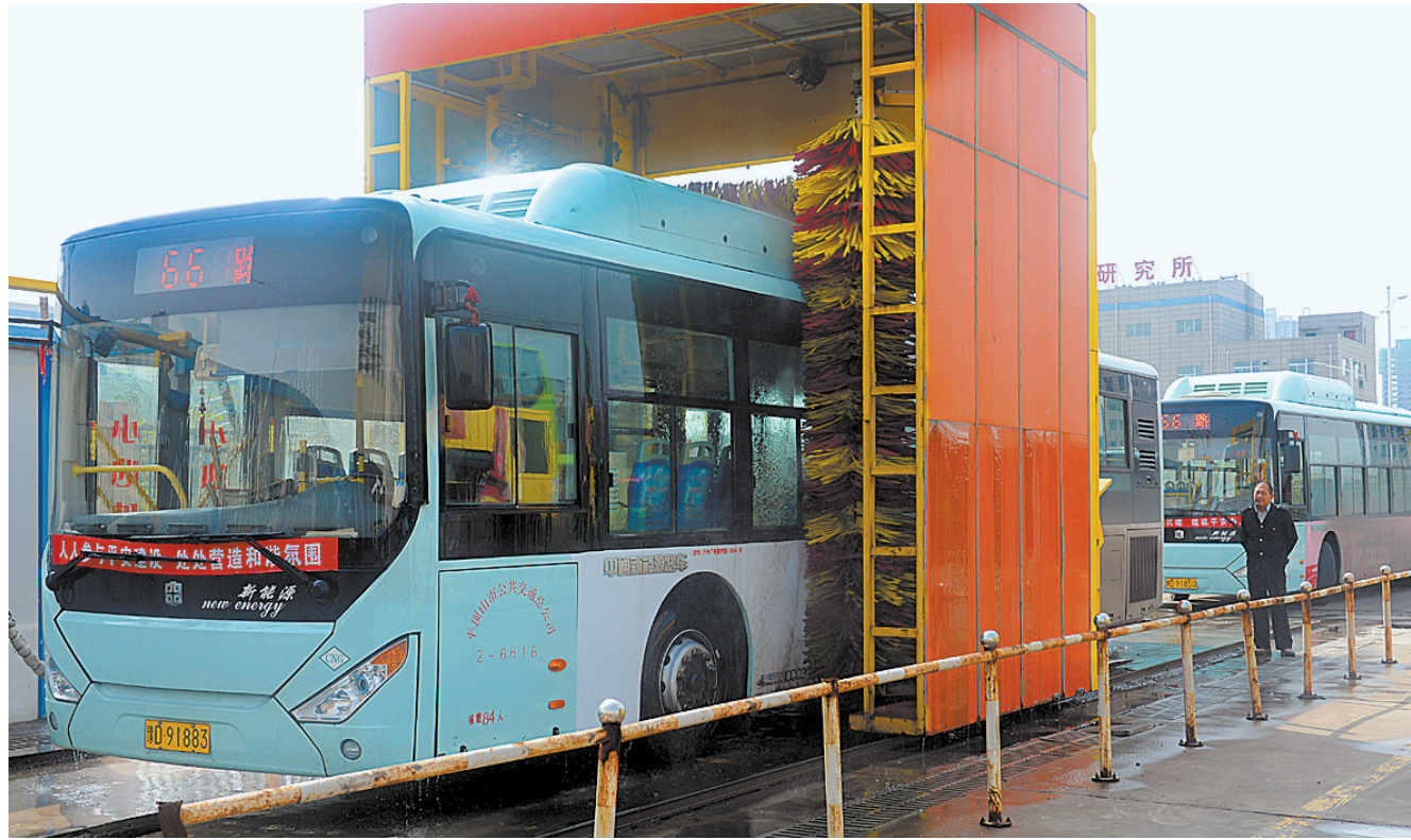
4月7日,工作人员遥控自动洗车机清洗公交车车体。市公交三公司通过技术改造,把车辆清洗产生的废水进行回收,经沉淀后再进行循环利用,在保证车辆外观整洁的同时显著减少了洗车用水量。本报记者 王尧 摄
