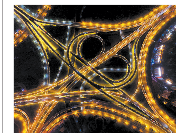
郑州金水立交桥
