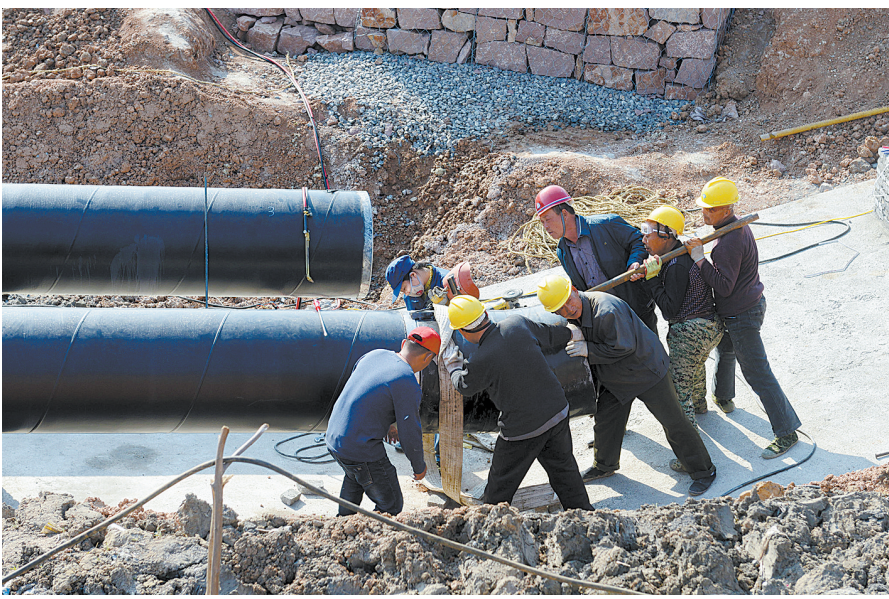
3月30日,工人们在湛南暗涵—稻田沟倒虹吸段施工现场调整管道弯头准备焊接。湛南暗涵—稻田沟倒虹吸段工程横跨湛河两岸,是湛河截污系统的重要组成部分。该项目投运后将使湛河上游北岸的污水通过倒虹吸进入湛南暗涵,并最终将其引入市一污水处理厂。截至目前,该项目倒虹吸管道铺设工作已完成过半。 本报记者 王尧 摄
