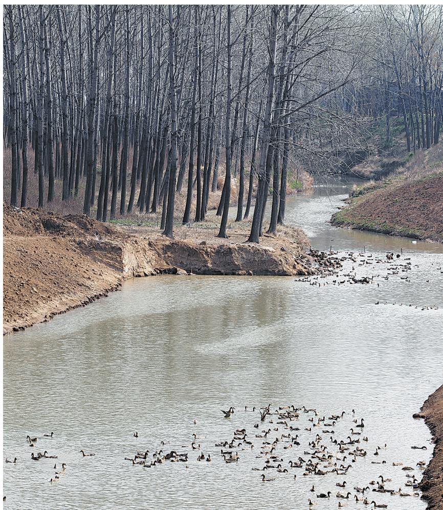
疏浚河道好行洪
