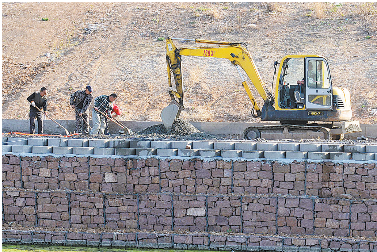
应用无砂混凝土铺设湛河一平台道路
