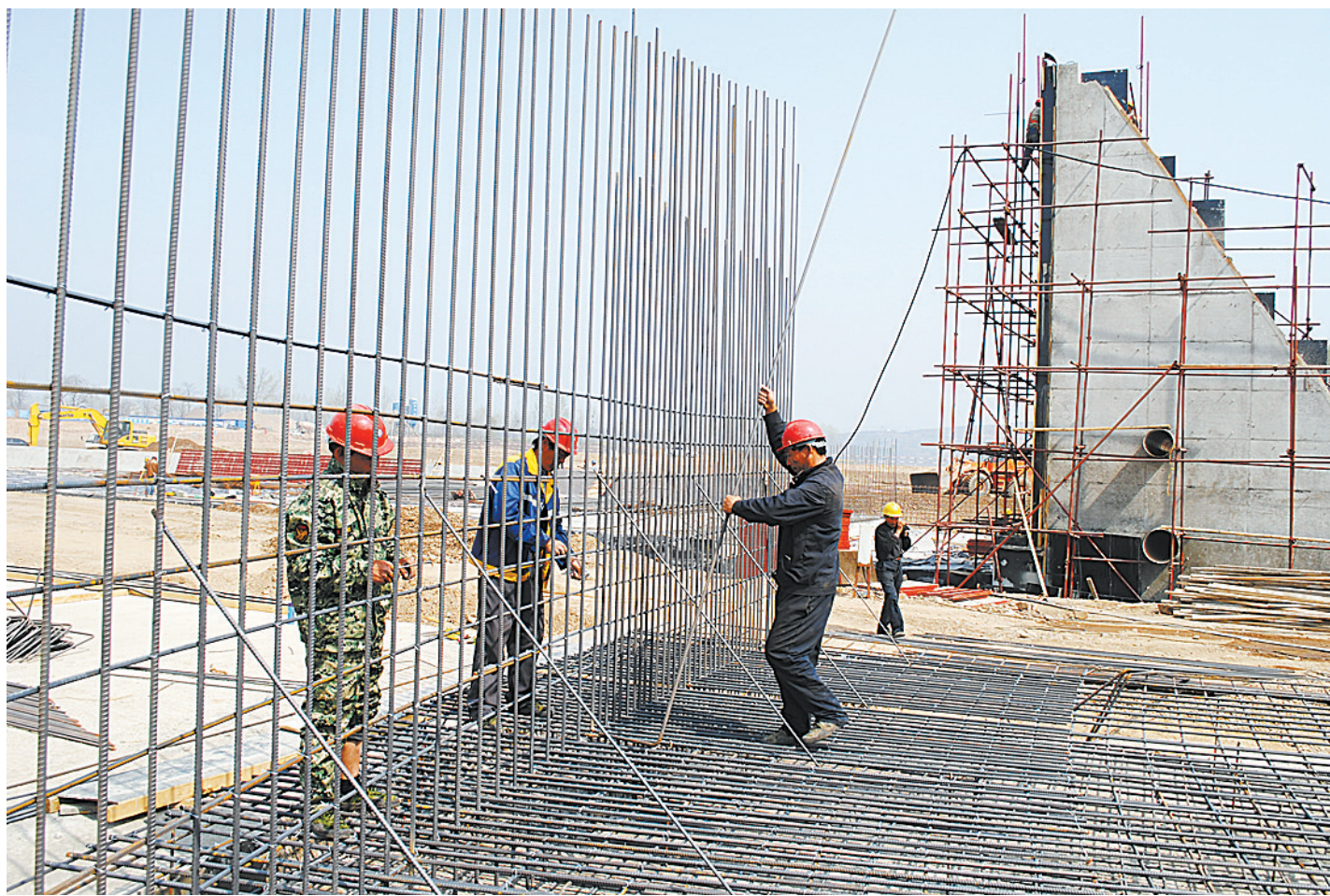
3月22日,在郟县堂街镇抗旱应急提水工程施工现场,工人师傅正在编织挡土墙钢筋网。该工程是河南省抗旱应急重点工程,位于北汝河郟县段堂街镇恒压喷灌工程水源泵站引水口下游150m处。工程建设内容主
