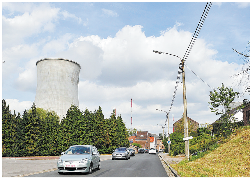
这是2012年8月22日拍摄的位于比利时首都布鲁塞尔东南约90公里的蒂昂核电站。3月22日上午在布鲁塞尔机场和地铁站发生的系列爆炸袭击已造成34人死亡...
