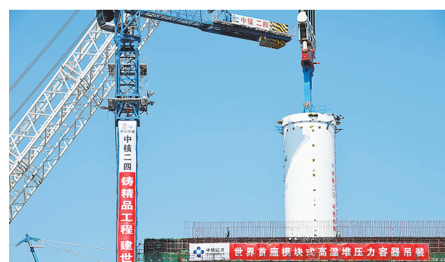
3月20日,在鲁能山东石岛湾核电厂,反应堆压力容器成功吊装进入核岛。当日,全球首座高温气冷堆示范工程压力容器在鲁能石岛湾核电厂吊装成功,标志着我国在高温气冷堆示范工程建设和核电装备制造两方面均取得重大突破。新华社记者 郭峰雷 摄
