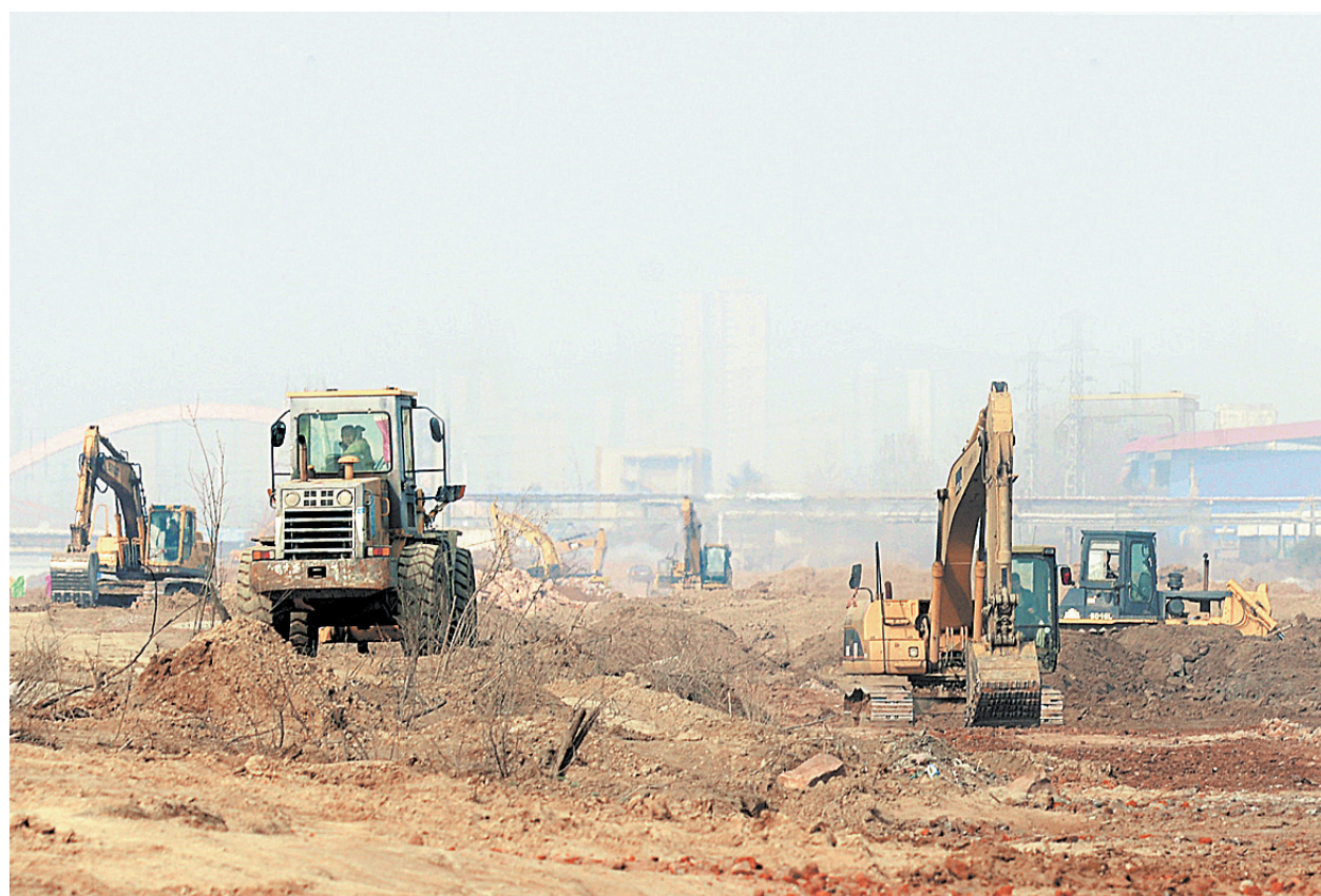
湛河综合治理2016年度第一批工程开工
