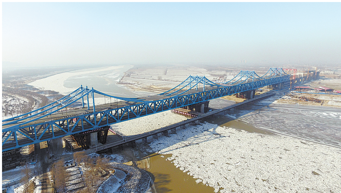
石济客专济南黄河公铁两用桥主梁完工
