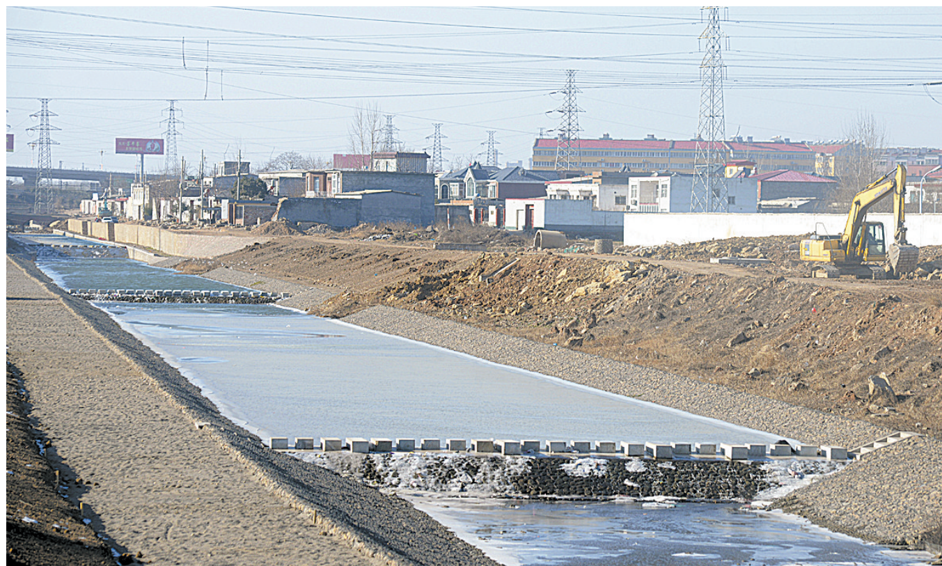
1月25日，施工人员驾驶挖掘机在平郟路淮河桥西侧平整基坑浇筑暗涵覆土。受持续低温天气影响，湛河上游河段出现冰封河面的景观。洁白的冰层和清澈的河水在如洗碧空的映衬下折射出蔚蓝色的光芒，为冬日的湛河平添了几分秀色。 本报记者 王尧 摄
