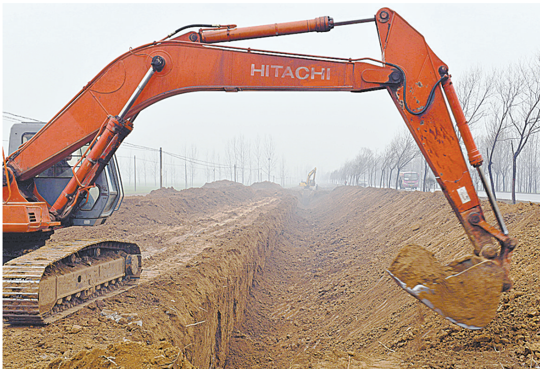
修水渠 防干旱
