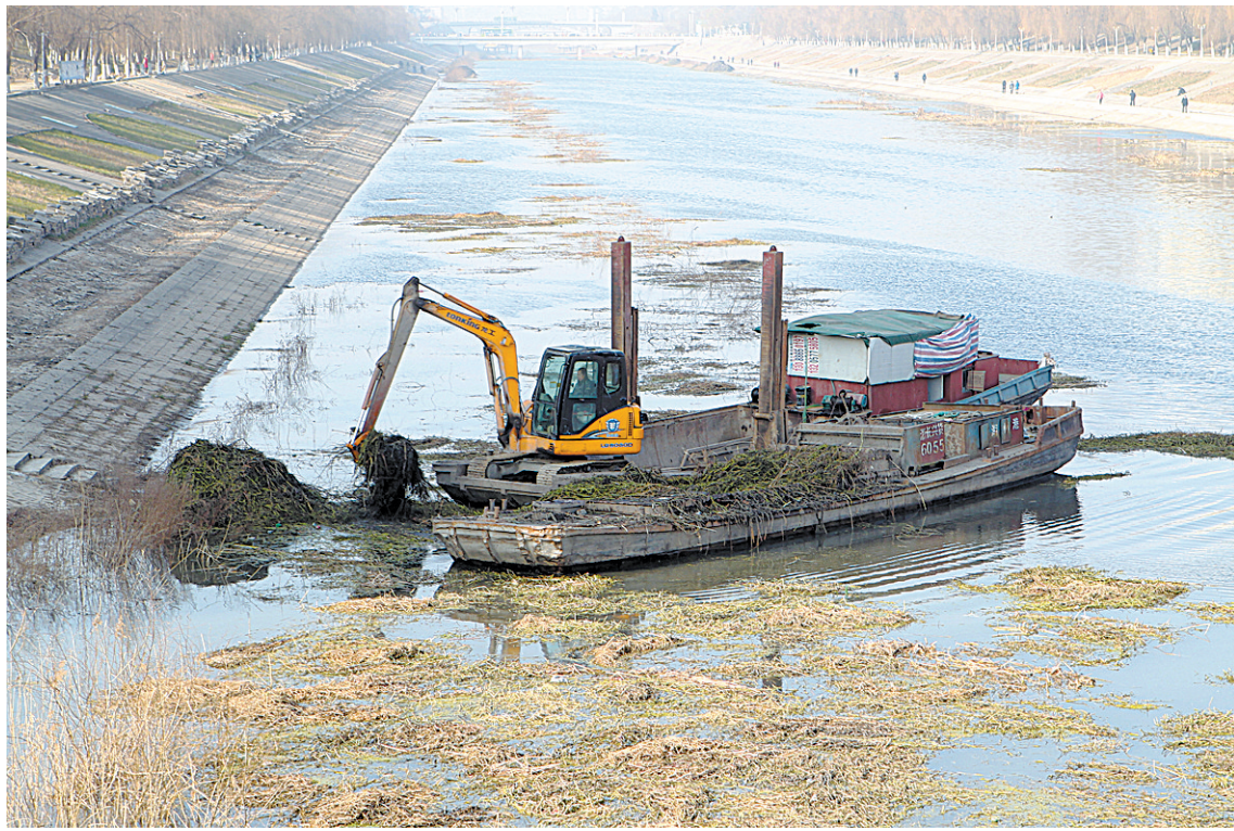
湛河清淤 除草进行中
