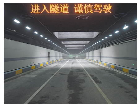
全国最长湖底隧道建成通车 12月28日,东湖隧道建成通车。经过3年多紧张施工,全国最长的湖底隧道武汉东湖隧道28日正式通车。全长10.6公里、双向6车道的东湖隧道,克服多项技术难题,通车后将大幅提升武汉城区路网交通便捷度。新华社发(程敏 摄)
