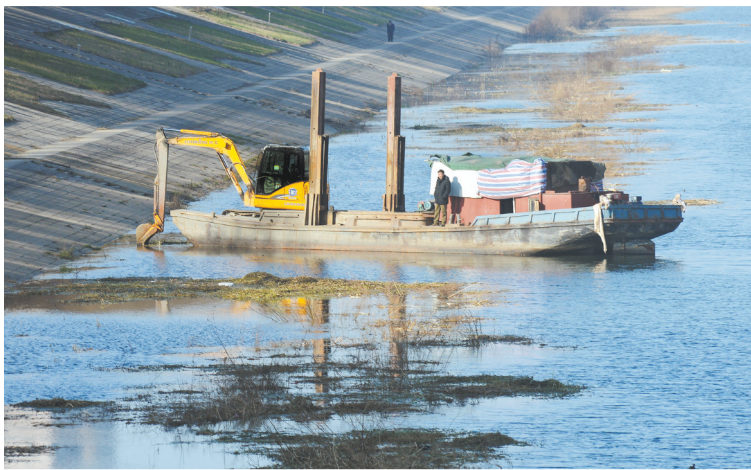
12月25日,施工人驾驶车载挖掘机在新华路淮河桥西侧清理淤泥上方的杂草和杂物。
