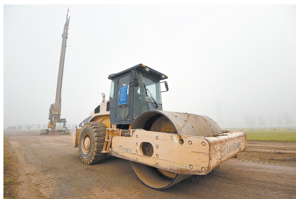
郑合高铁河南段开工建设
