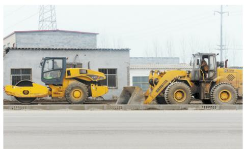
12月16日,施工机械平整快速通道非机动车道路基。排水管网工程已基本完工,施工单位正抓紧推进非机动车道路基修筑和沿线配套设施建设。本报记者 王尧 摄
