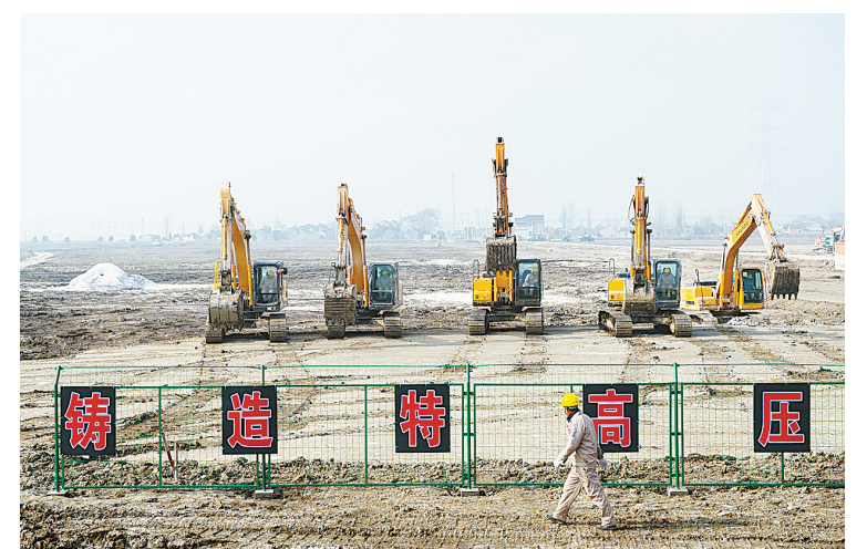
锡盟-泰州±800千伏特高压直流输电工程开工
