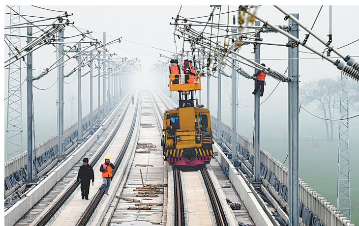
郑徐客运专线电气化施工进入冲刺阶段
