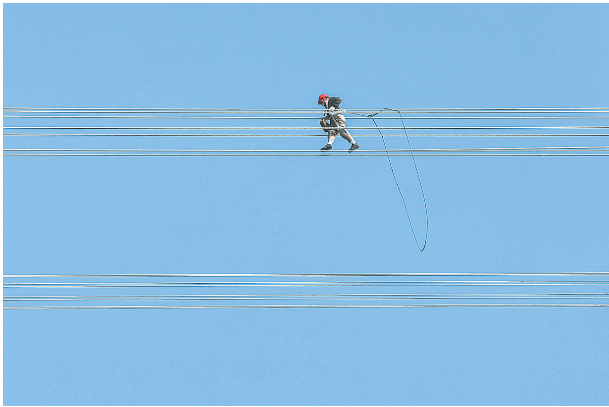
11月27日,技术人员在“淮上线”特高压输电工程江苏淮安盱眙县境内的线路上进行验收作业。
