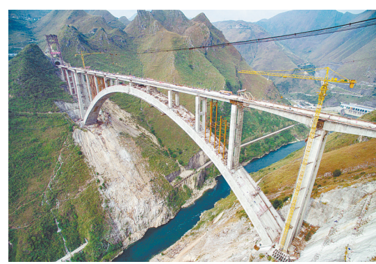
11月19日,位于贵州省安顺市境内的沪昆高铁北盘江特大桥顺利合龙,标志着沪昆高铁全线控制性工程建设取得重大成果。新华社记者 刘续 摄
