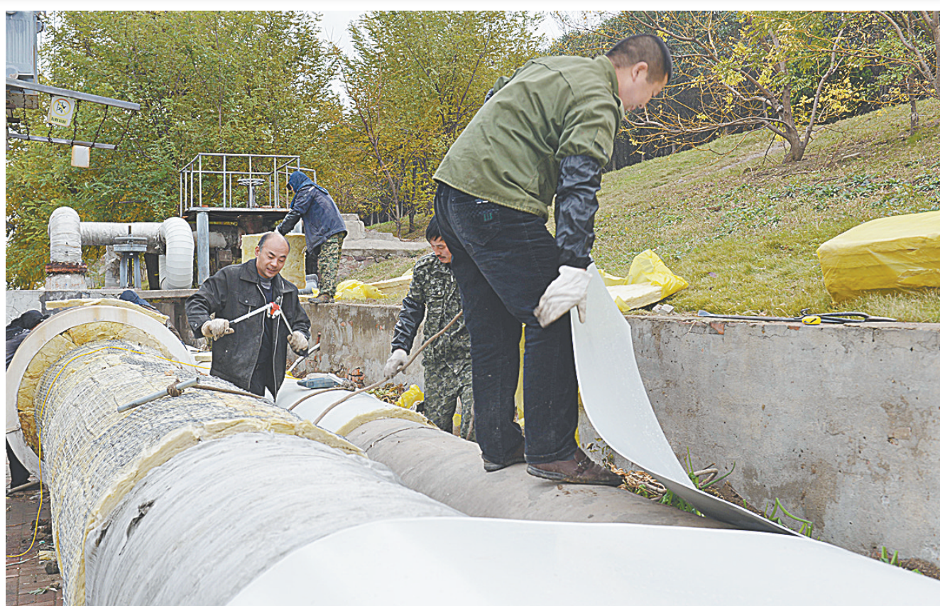
修护供热管道
