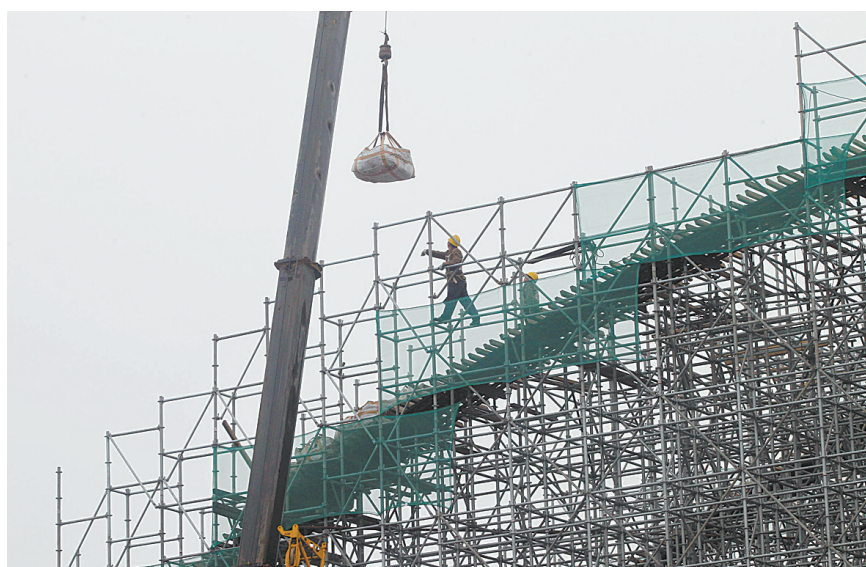
架设特大铁路桥
