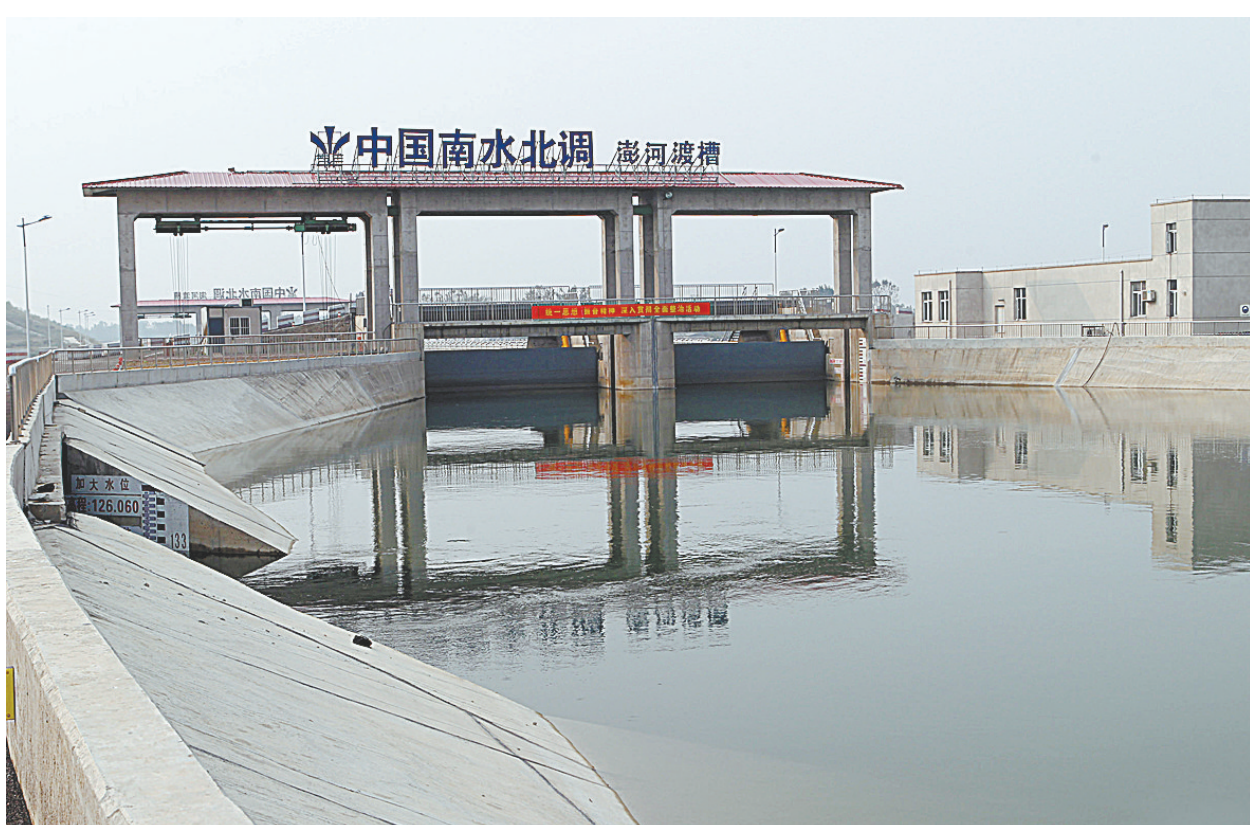
11月12日,源源不断的清水流过南水北调中线工程滏河分水口门奔向鹰城。我市是南水北调中线工程首个受益城市,该工程去年12月12日建成通水以来,大量补充水源通过滏河分水口门流进我市白龟山水库。
