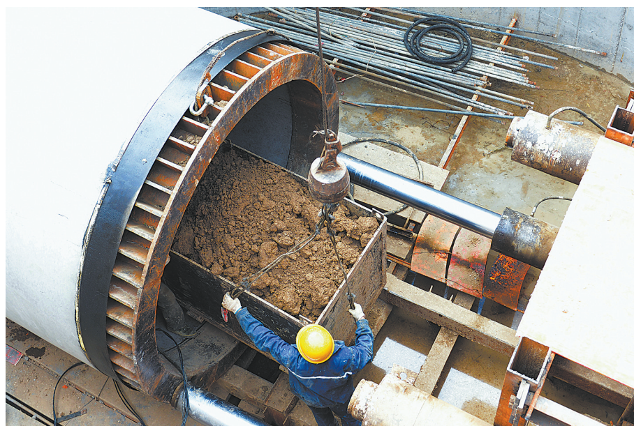
11月2日,施工人员在顶管工作井内配合吊车将顶进产生的渣土运出管道。
