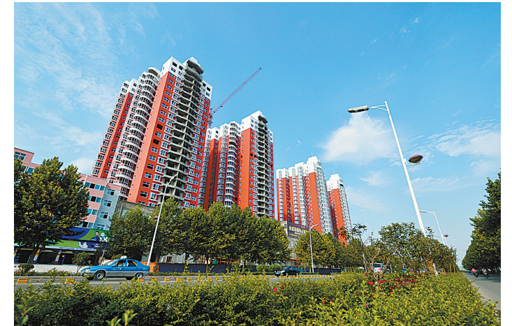
建设中的房产项目
