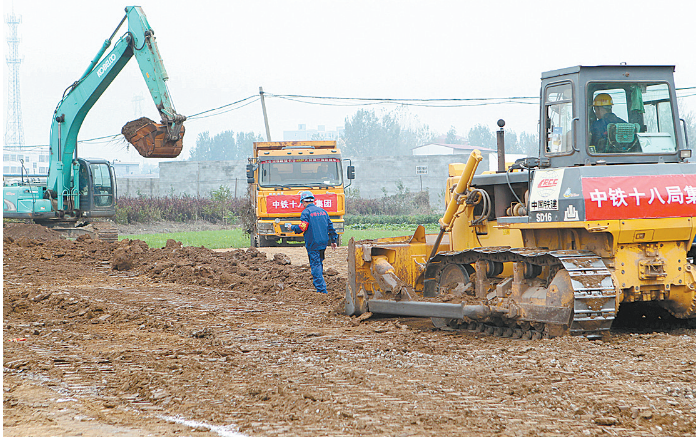
10月31日,施工人员在鲁山县辛集乡柴庄村的郑万铁路建设工地上紧张施工。郑万铁路是我省“米”字形快速铁路网的重要组成部分,平顶山段中的13多公里于当日先期开工建设。 本报记者 姜涛 摄
