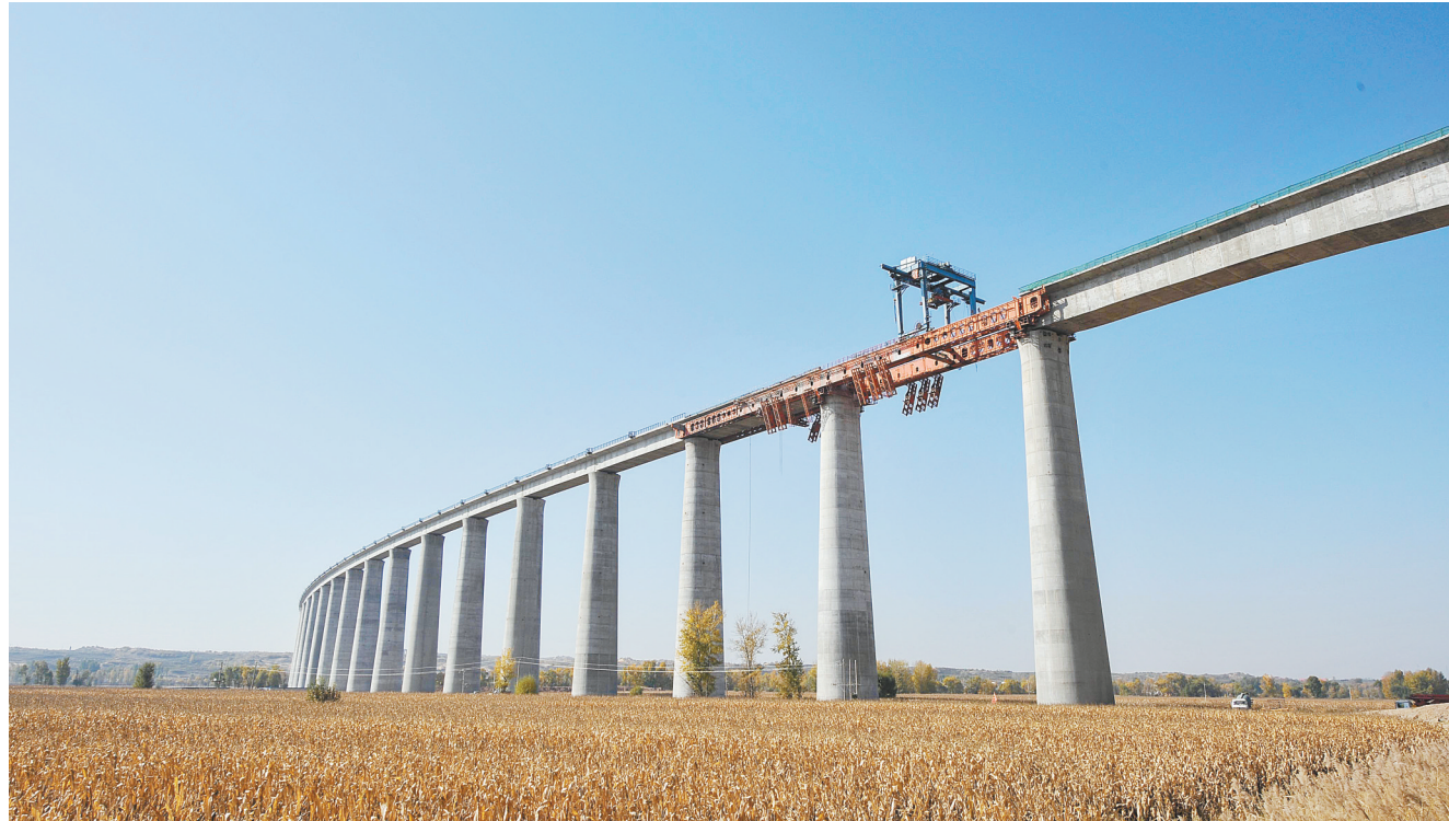
10月16日，内蒙古自治区呼准鄂铁路黄河特大桥顺利合龙。呼准鄂铁路黄河特大桥全长4910米，其中主桥长1037米，是全国最长的墩梁刚性连接的连续梁铁路大桥。呼准鄂铁路为万吨重载客货混用国
