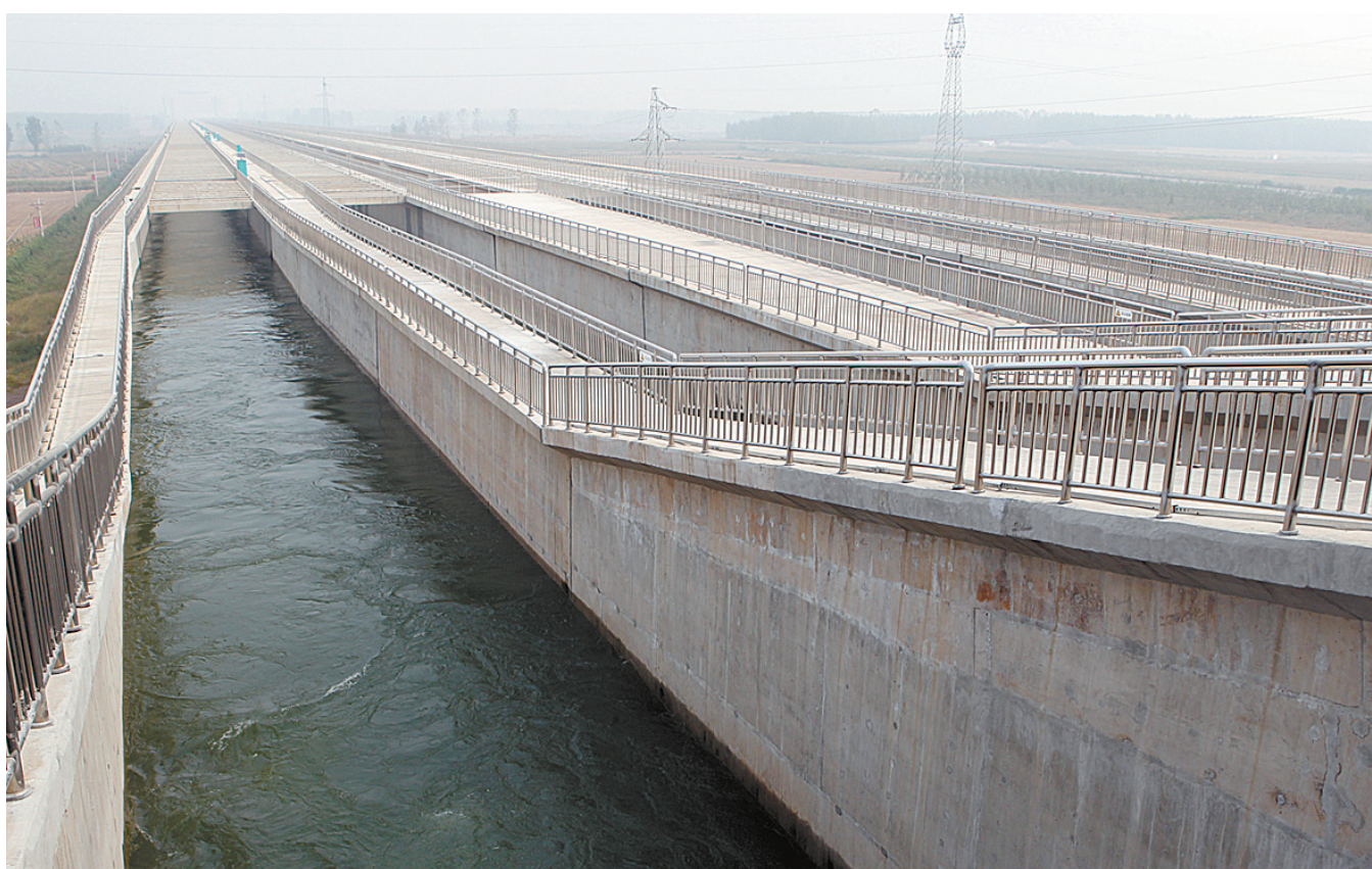
沙河渡槽运行良好
