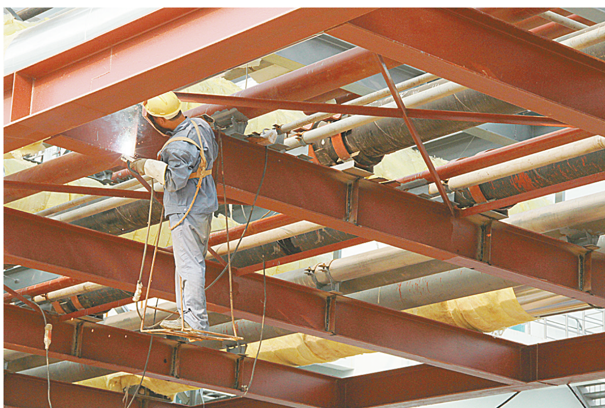
9月9日下午,工人正在施工。地处平顶山化工产业集聚区的双30万吨己内酰胺项目是
