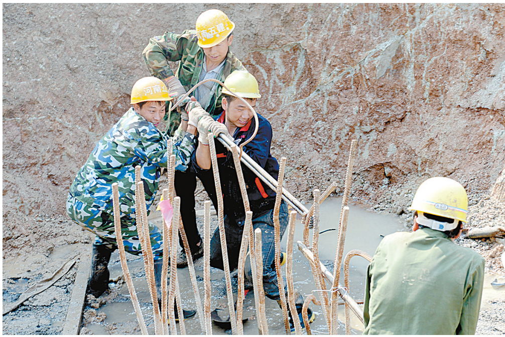
工人们在湛河上游水泥厂桥施工现场将弯曲的桩头钢筋扳正。 本报记者 王尧 摄
