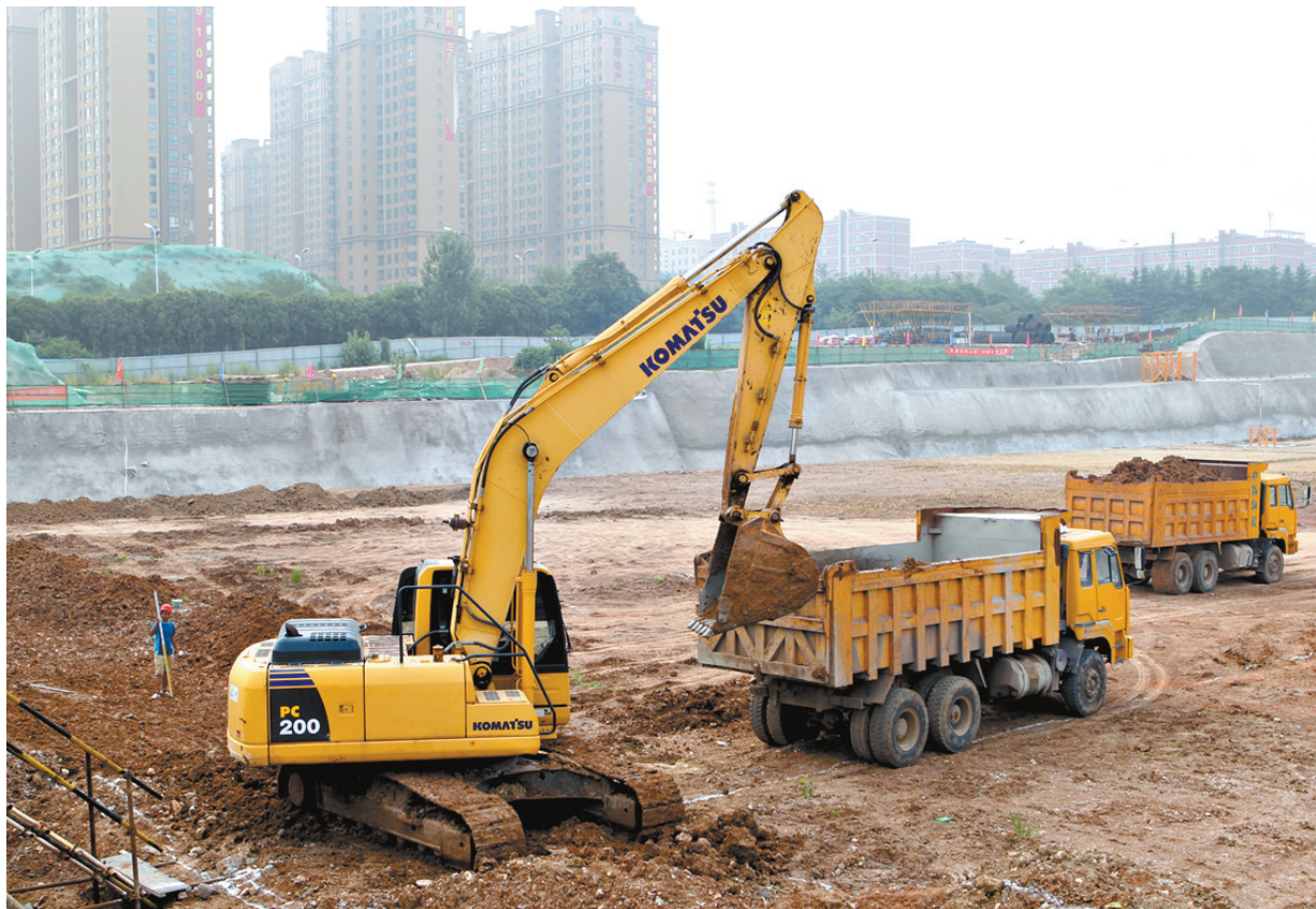
加快工程建设进度
