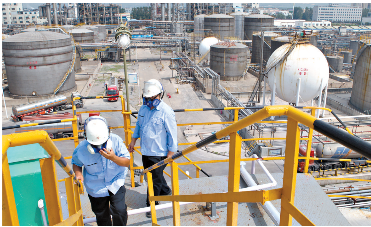
检查罐体安全
