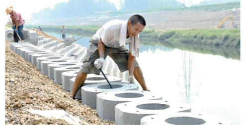
8月11日,施工人员在湛河治理工程国铁桥至许南路标段河道北岸安放多边形空心混凝土砌块。湛河治理工程国铁桥至许南路段全长7.25公里。施工工人通过将空心砌块上下互相叠形成可容纳保护棒、混凝土或营养土的内部空间,既牢固又美观。 本报记者 王尧 摄
