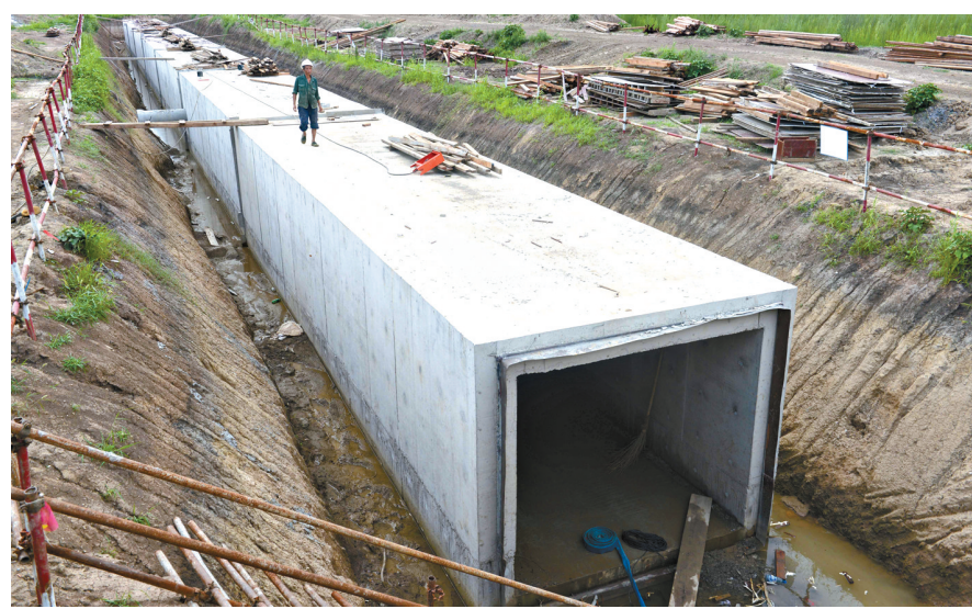
施工人员在湛南暗涵试验段箱涵顶部徒步观察外观质量。本报记者 王尧 摄
