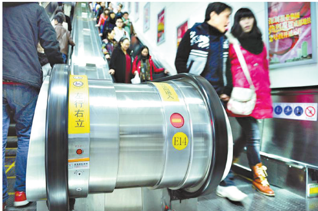
出现突发状况时,按下紧急停止按钮可使电梯停运(资料图片)
