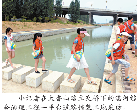
小记者在大香山路立交桥下的湛河综合治理工程一平台道路铺装工地采访。
