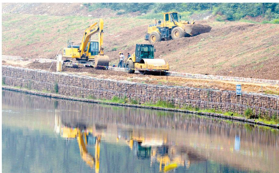
7月26日,工人在湛河治理工程程香路至凌云路段河道北岸修筑一平台路基。程香路至凌云路段全长1119米,施工项目包括河道疏浚、护岸、边坡防护等,是湛河治理市区段的重要组成部分。目前,该标段河道治理及两岸护坡工程已基本完工,施工单位正抓紧修筑两岸一平台路基。 本报记者 王尧 摄
