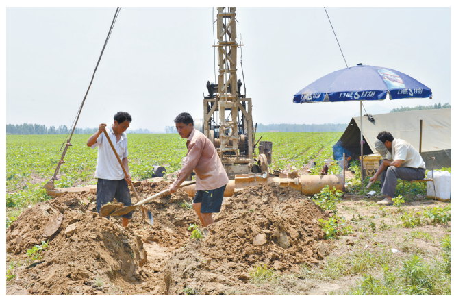
7月24日,打井队在叶县龙泉乡南栗庄村田间打井。该村共有耕地3650亩,灌溉条件较差。他们积极争取农业开发项目资金,为村民打井60眼。本报记者 牛智广 摄
