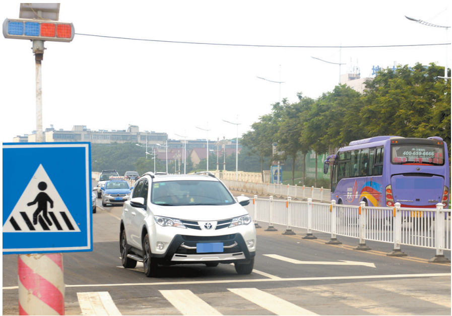
7月20日,来往车辆从恢复通行的凌云路湛河桥上驶过。 本报记者 王尧 摄
