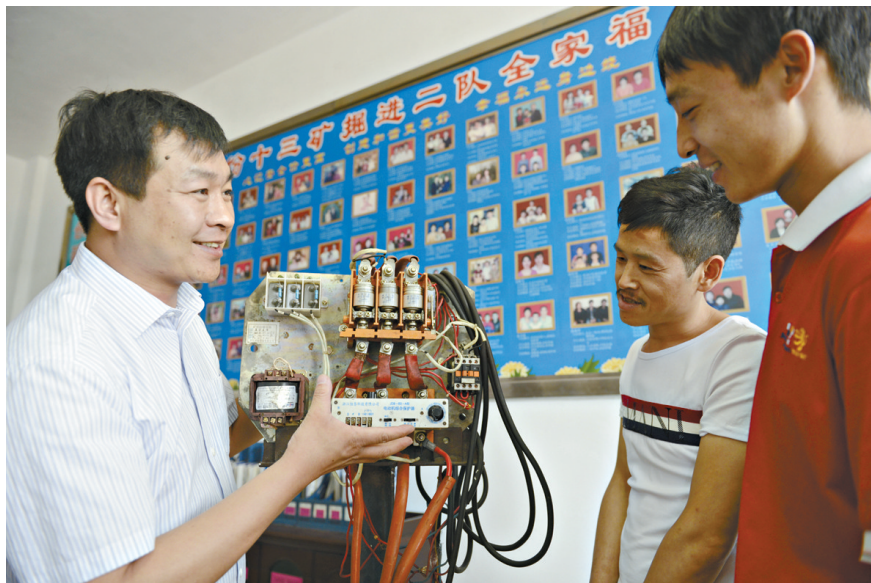
王羊娃正在给本队职工讲解井下防爆开关维修技术。 郭建华 摄
