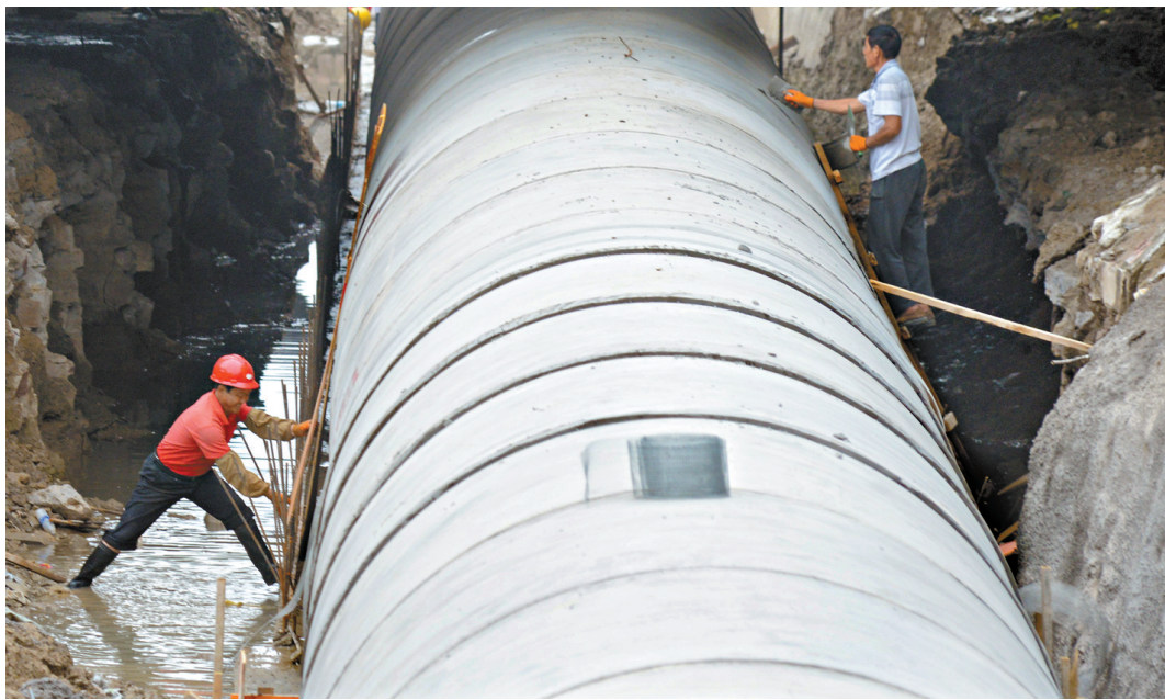
加快推进淇河治理工程
