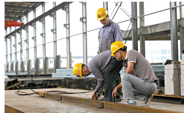
7月16日,工人在车间焊接工件。去年5月,河南华中神力特种钢结构有限公司在郟县产业集聚区投资9.6亿元建设特高压管塔项目,主要生产科技含量较高的特高压管塔,达产后可实现年销售收入15亿元,安排1000余人就业。
