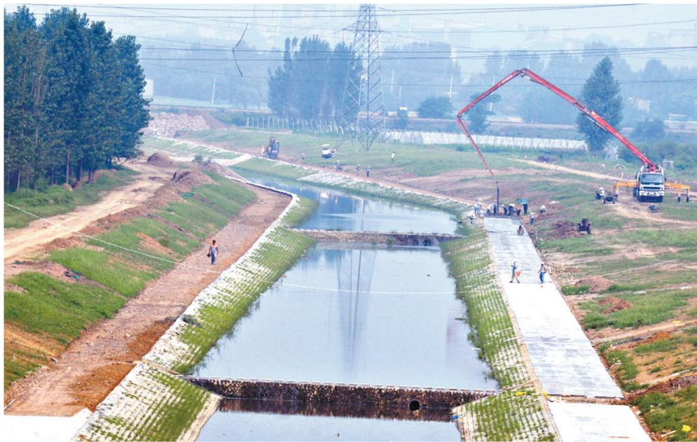
7月12日,施工人员在漯河治理工程石桥营至大香山路桥段配合混凝土泵车浇筑北岸堤顶路面。该项目堤顶路面平整工作已基本结束,建设单位正抓紧推进堤顶路面和跨河桥梁修筑工作。本报记者 王尧 摄
